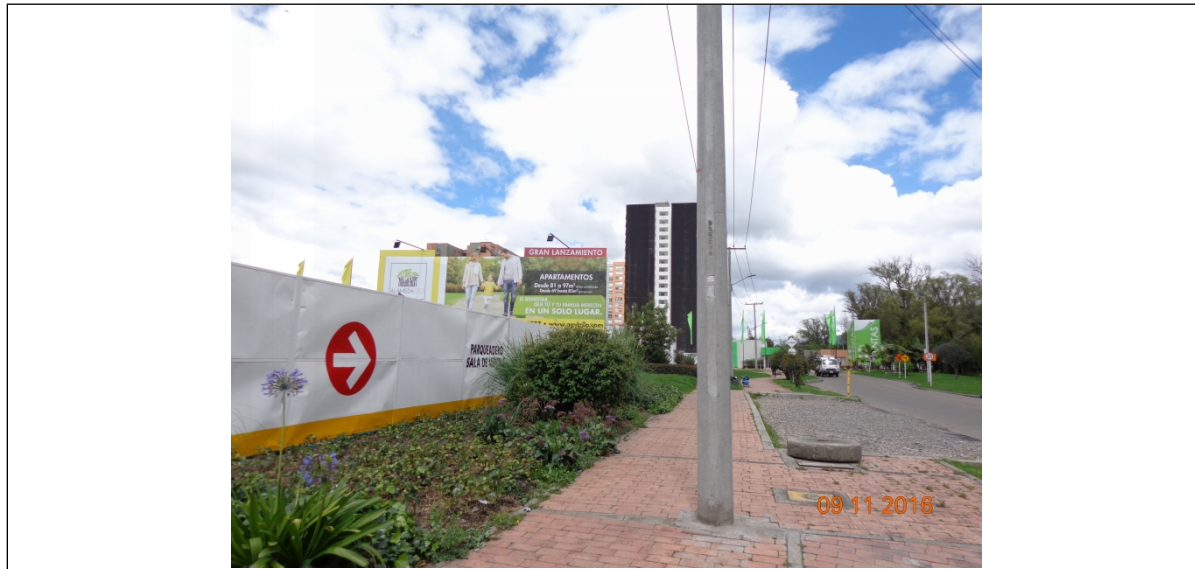
Fotografía No. 1 Vista panorámica de los elementos tipo Valla de Obra Convencional ubicada en la Carrera 15 No. 170 – 91.
